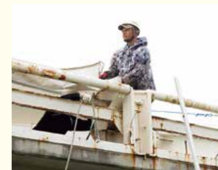
利尻高校のプールの屋根貼りの作業風景。いつも夕方には自宅に帰り、家族との充実した時間に安らぐ千田さん。
