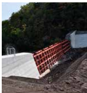
令和2年の土石流を堰き止めた砂防ダム（オチウシナイ川上流部）（伊藤さん提供）
